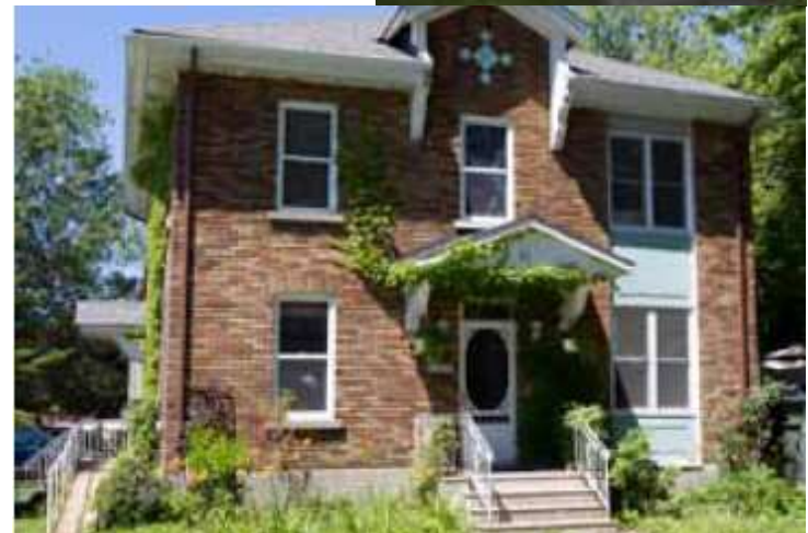
Photos : Circuit pédestre, Le Quartier-du-Moulin, sous le charme de la Nouvelle-Angleterre, Ville de Gatineau (façades de maisons patrimoniales sur la rue Poplar)
